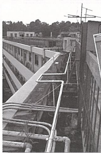
⑤本館屋上に施工中のパイプライン(初めてのSUS自動溶接)
